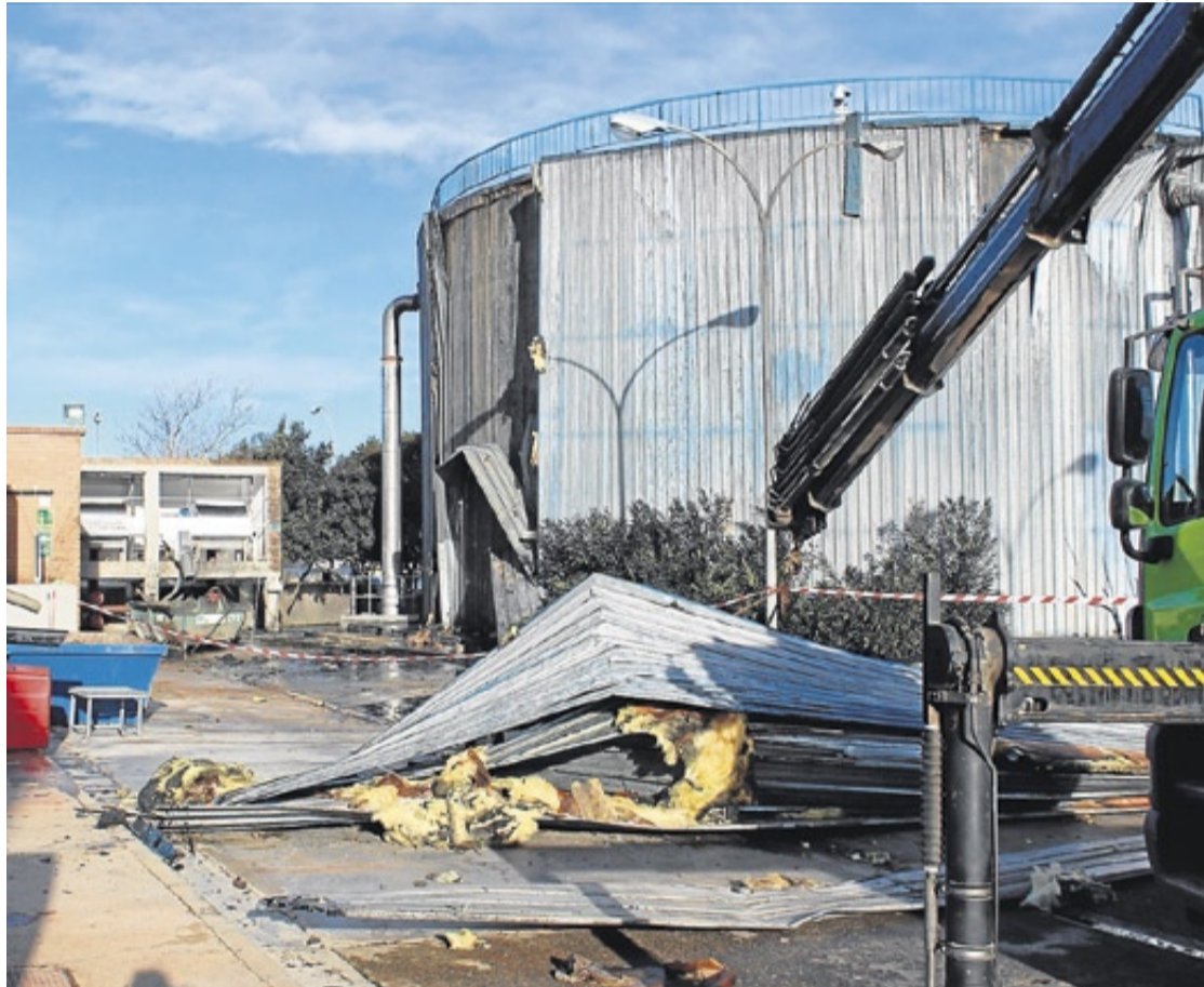
Averiado. El digestor de fangos de la depuradora de La Almozara, que se averió la semana pasada.
